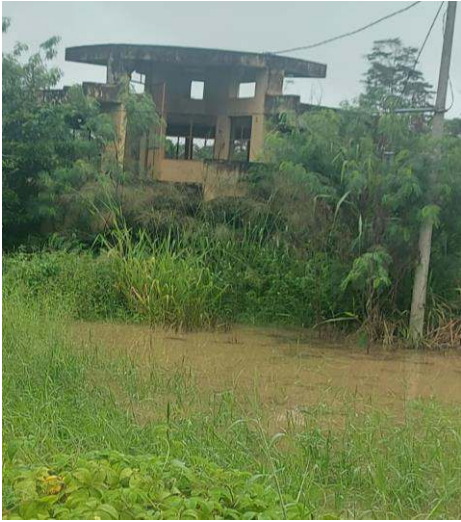
SE APRECIA LA INUNDACION DE LA PLANTA DE TRATAMIENTO DE AGUAS RESIDUALES DE LA LOCALIDAD DE PUERTO RICO POR DESBORDES DEL RIO HUALLAGA Y REPRESENTANDO DEL DREN HUALLAJUNCO.
